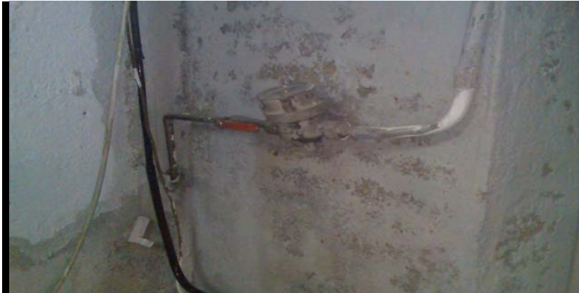
Tubería de plomo
